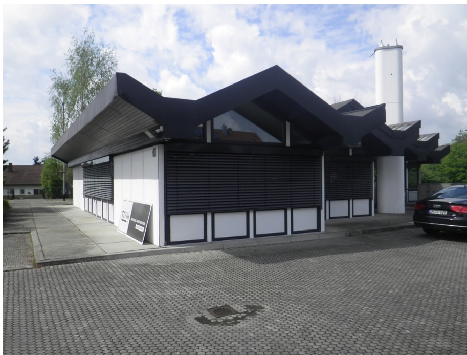
Abb. 3: ehemaliges Gebäude der Raiffeisenbank auf Flurnummer 1234/80
