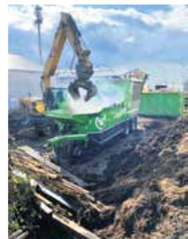
Dank Magnetabscheider wird ein Großteil der Nägel und Eisen aussortiert.
