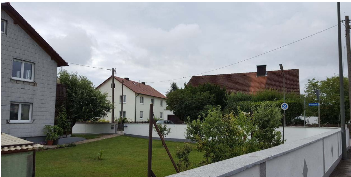
Abb. 3: Bestandsgebäude entlang dem „Zieglerweg“ (Foto: Jocham, Juli 2016)
